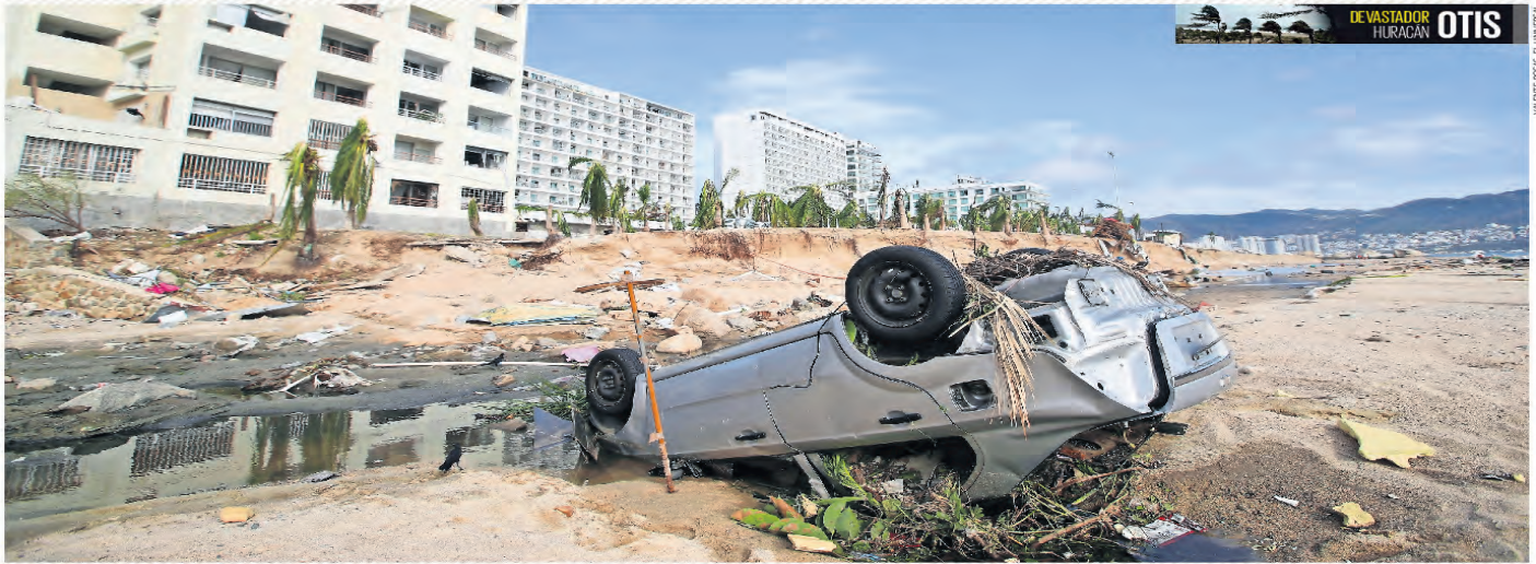
Un panorama desolador es lo que se ve tras el paso del huracán. Palmeras cabizbajas, hoteles y condominios dañados en una de las zonas más glamorosas del puerto de Acapulco.
